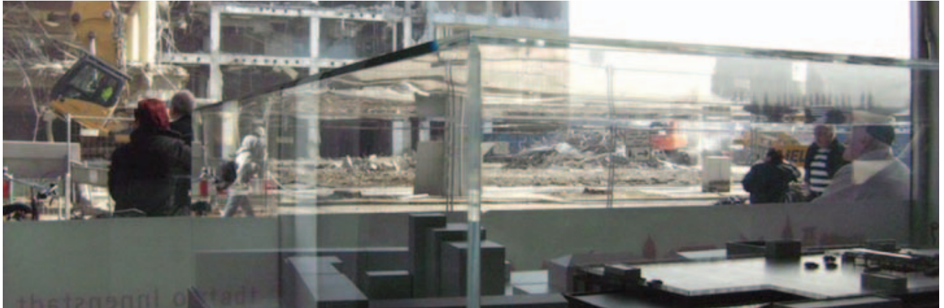
Abb. 1: Blick aus dem Projektbüro während des Abrisses des Hertie-Warenhauses
