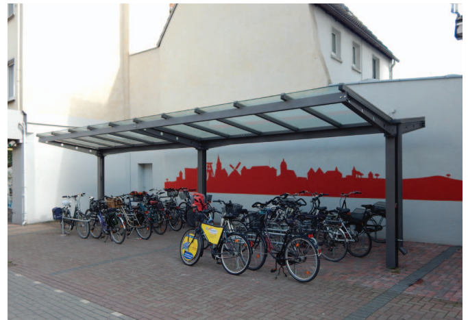
Abb. 15: Radabstellanlage Friedrich-Ebert-Straße (nachher)
