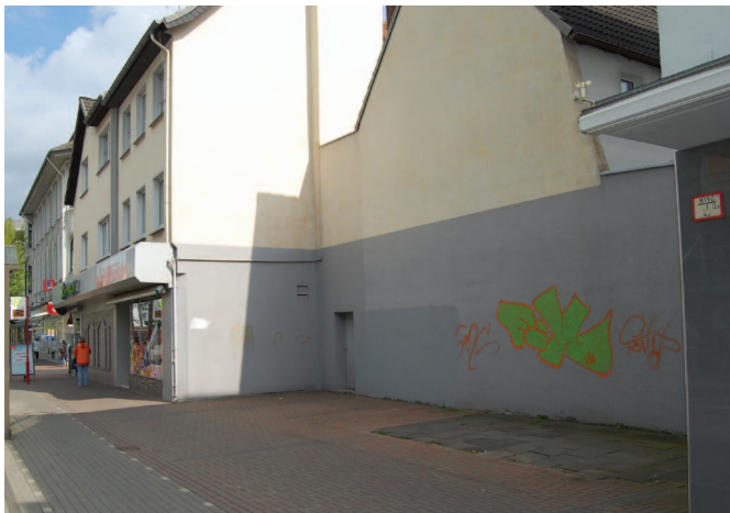
Abb. 14: Radabstellanlage Friedrich-Ebert-Straße (vorher)
